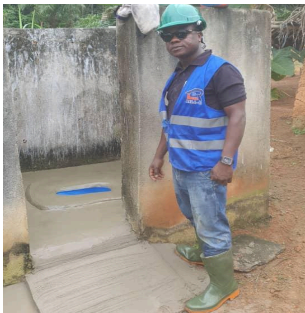
Ambroise Tiemoko près d'une installation sanitaire qu'il a construite à San Pedro.
